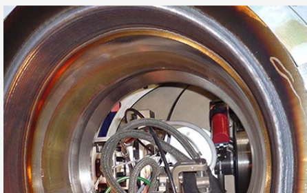
EDF-UTO - Réparation des piquages du Circuit Primaire Principal
