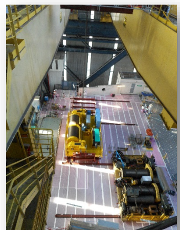
EDF Rénovation ponts Bugey 1
